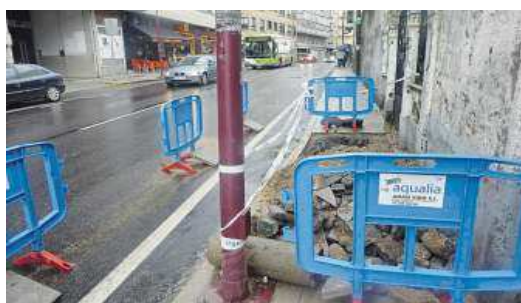
Reparación de Aqualia en una tubería de uralita en Teis. CEDIDA
